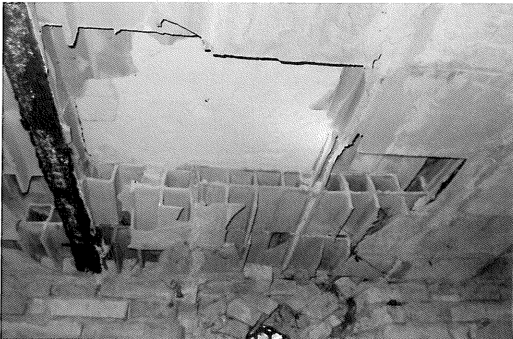
9-10 PIANO INTERRATO: SFONDELLAMENTO DEL LATERIZIO
