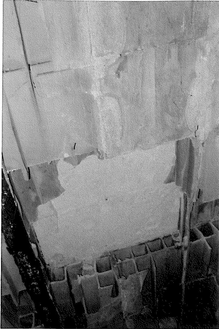
9-10 PIANO INTERRATO: SFONDELLAMENTO DEL LATERIZIO
